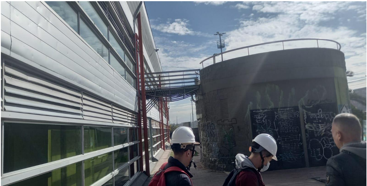
Ilustración 7. Fachada Supercade Américas Carrera 86 # 43-55 Sur. Autor: KRIBA INGENIEROS LTDA.
